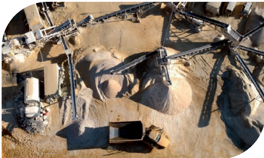
Source : Exploitation – Stock Photos (Bim).
